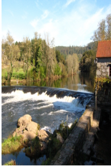
Vista de presa e muiño
