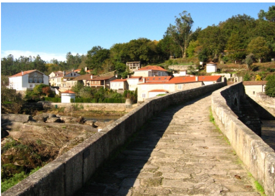
Entrada do Camiño en Negreira pola ponte de Pontemaceira
